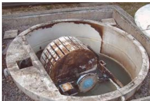
Obr. 6: ČOV s nárůstovými kulturami.
